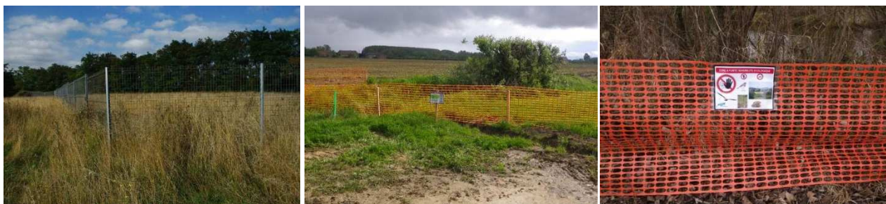
Figure 45 : dispositifs de chantier de balisage et de protection du milieu naturel
